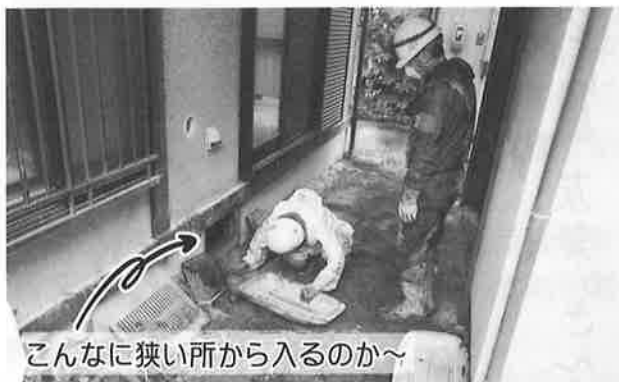
床下換気口から断熱材を運び出す様子
