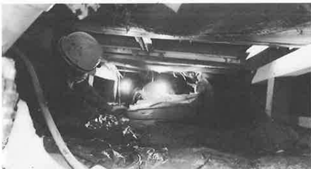
床下での作業の様子
